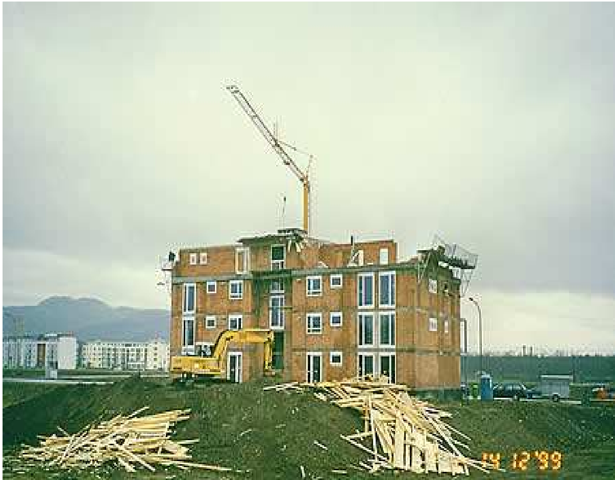
Dachstuhl eines Mehrfamilienhauses
